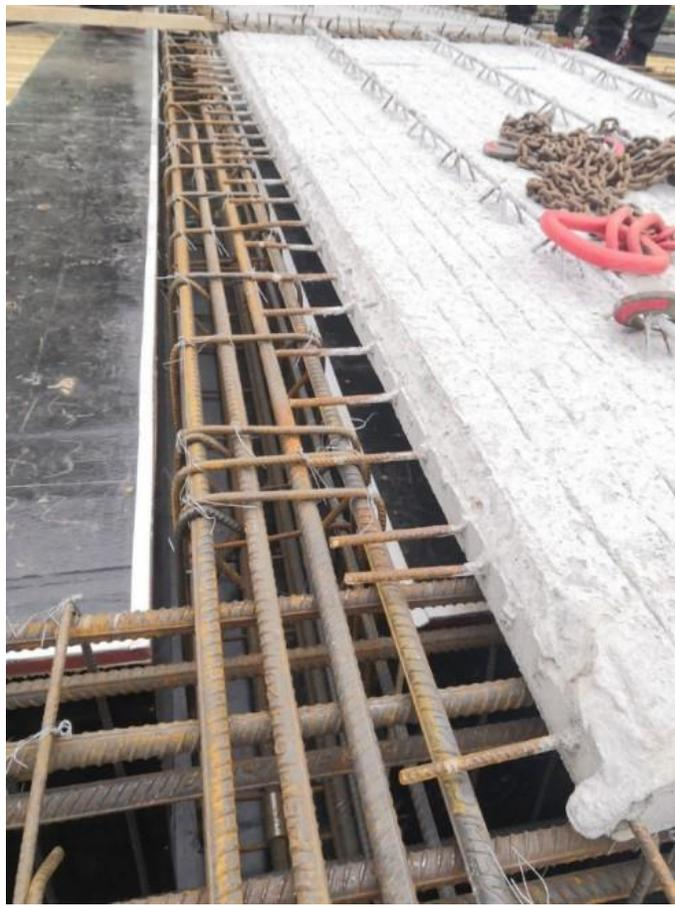
先绑梁钢筋后放叠合板
