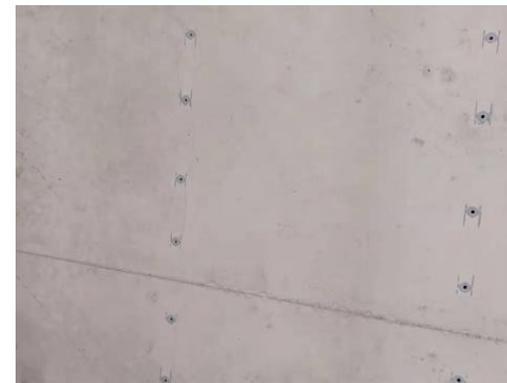
**可拆底模钢筋桁架楼承板：**钢筋桁架与可拆底模通过专用连接件连接成整体的组合承重板。
