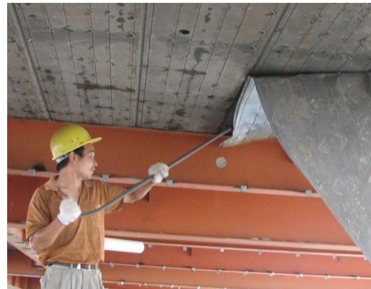
**焊接式钢筋桁架楼承板：**由钢筋桁架与压型钢板通过电阻点焊连接成整体的组合承重板
