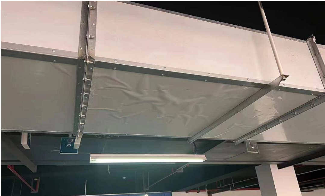
玻镁板含氯离子导致彩钢板氧化生锈鼓包
