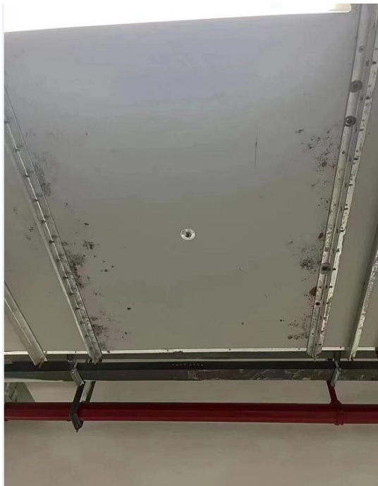
玻镁板受潮反卤导致外钢板及法兰生锈
