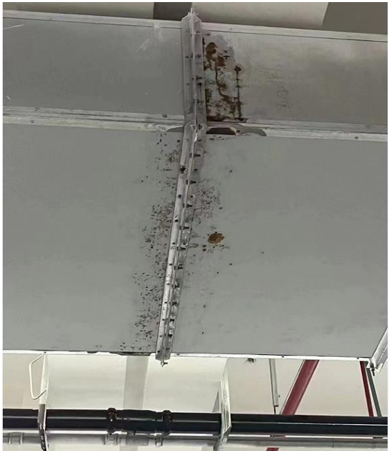
玻镁板受潮反卤导致外钢板及法兰生锈
